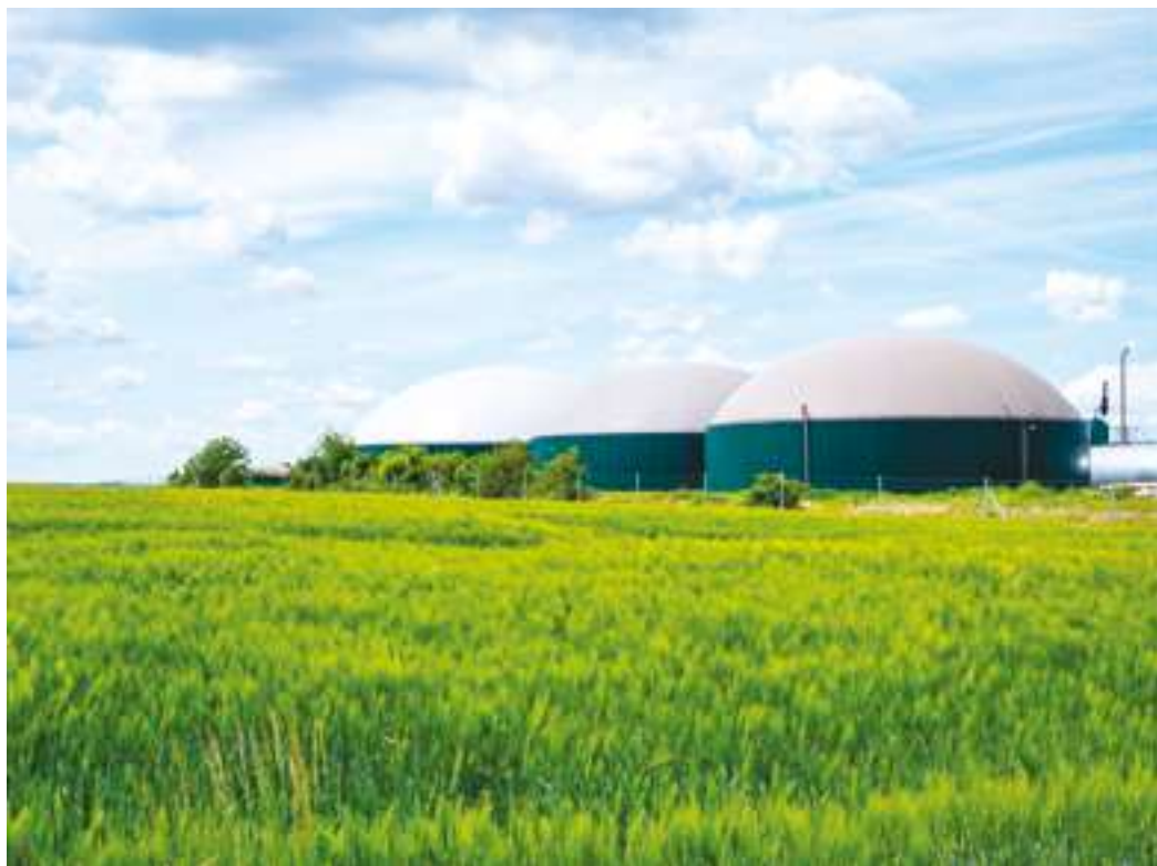
Usine de production de biogaz
